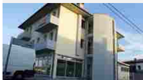
Palazzo in ristrutturazione, bimbo di 4 anni cade dal pianerottolo
